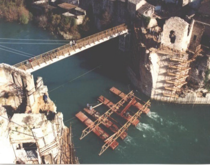
Resim 9: Geçiçi Yaya Köprüsü Resim
