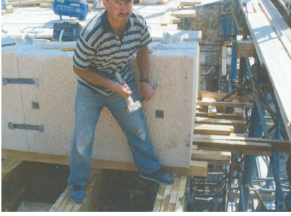
Resim 32, 33: Kanal Açma ve Harç İşleri
