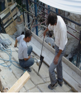
Resim 42, 43, 44: Kurşun Dökme, Kenet ve Zıvana İşleri.
