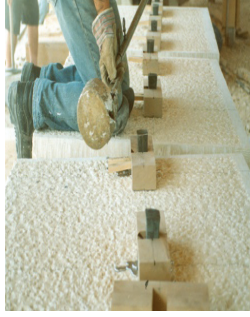
Resim 27, 28, 29: Yonu Taşı Hazırlama ve Yüz Açma ile Kurşun Dökme
