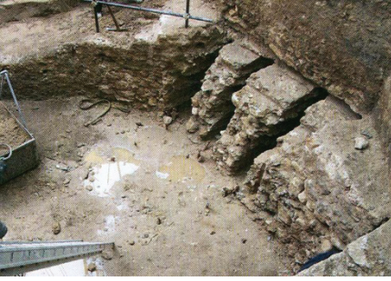
Resim 11: Ahşap Köprüye Ait Kiriş Yerleri Resim
