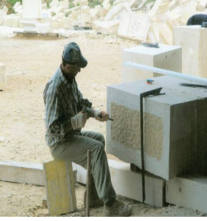
Resim 27, 28, 29: Yonu Taşı Hazırlama ve Yüz Açma ile Kurşun Dökme
