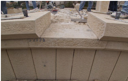
Resim 38, 39: Alt ve Üst Kornişin Yapımı
