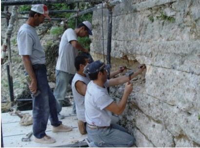
Resim 23, 24: Beden ve Kanat Duvarlarındaki Sağlamlaştırma
