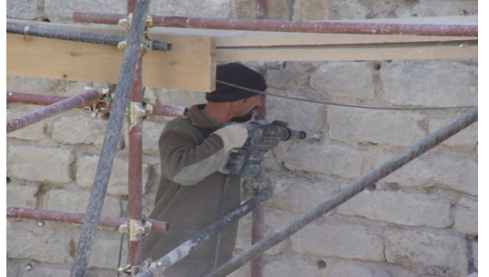
Resim 23, 24: Beden ve Kanat Duvarlarındaki Sağlamlaştırma
