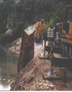
Resim 13, 14, 15: Dere Yatağındaki Özgün Kemer Taşlarının Çıkarılması.
