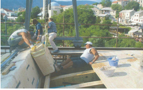
Resim 34, 35: Kemer Taşlarının Kenetli ve Zıvanalı Yerleştirilmesi
