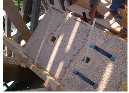
Resim 34, 35: Kemer Taşlarının Kenetli ve Zıvanalı Yerleştirilmesi
