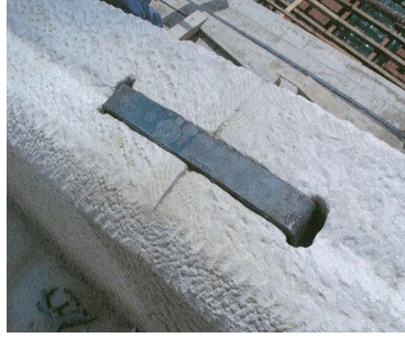
Resim 42, 43, 44: Kurşun Dökme, Kenet ve Zıvana İşleri.
