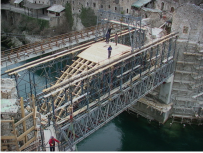
Resim 21, 22: Geçici Ayaklar Üzerine Oturtulan Taşıyıcı İskele ile İş İskeleleri.
