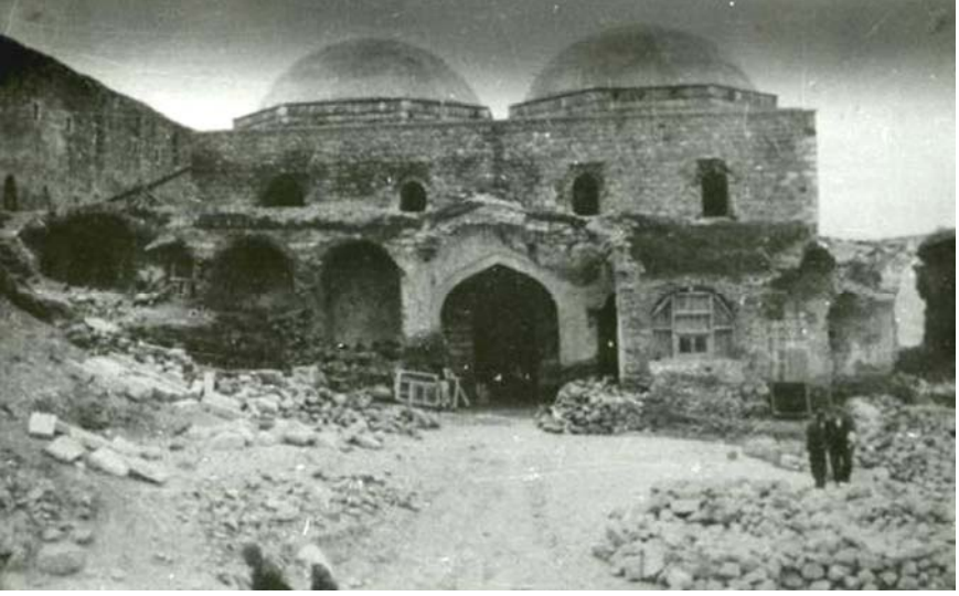
Resim 5: Mahmut Paşa Bedesteni Restorasyon Öncesi
