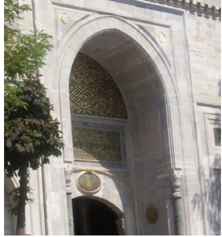
Şekil 38: Topkapı Sarayı Bâb-ı Hümayûn kapısı üzerinde yer alan kitabe (Etikan 2006).
